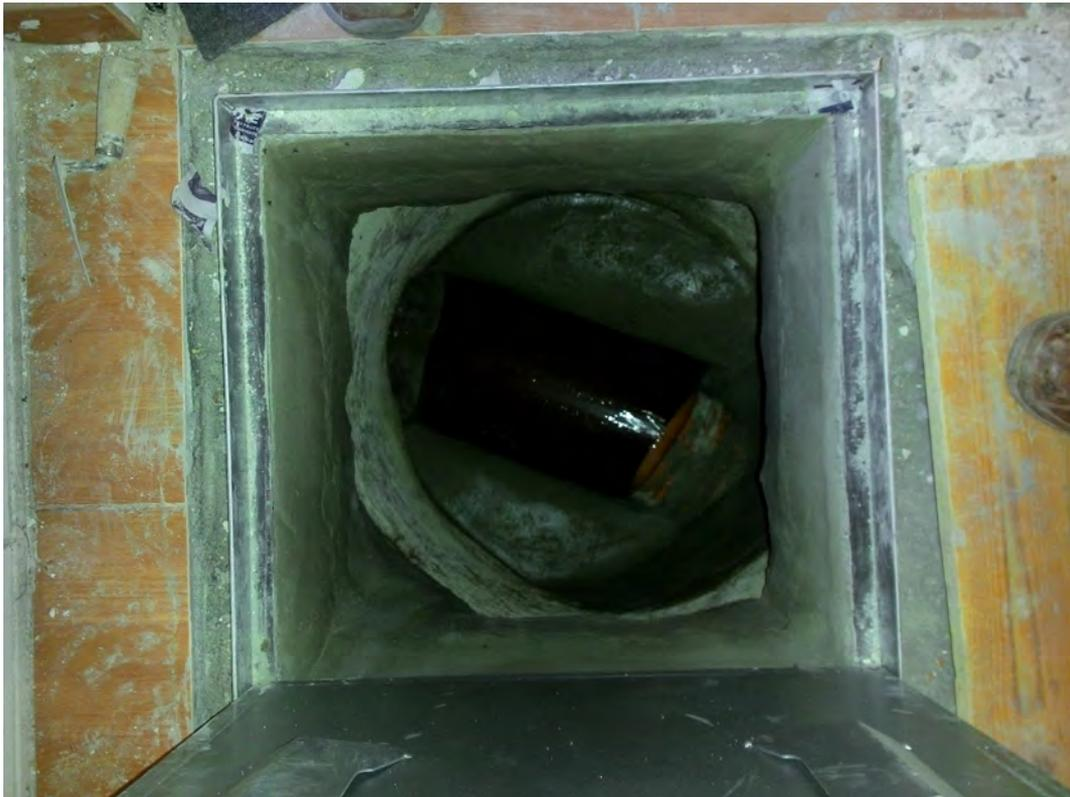
Fig. 8: Tapa abierta en una arqueta, para acceso a una conducción al objeto de realizar tareas de limpieza y desatranco.
