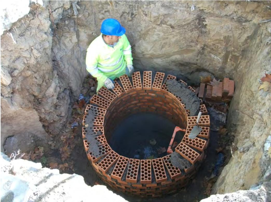
Fig. 18: Trabajos de ejecución de un pozo.
