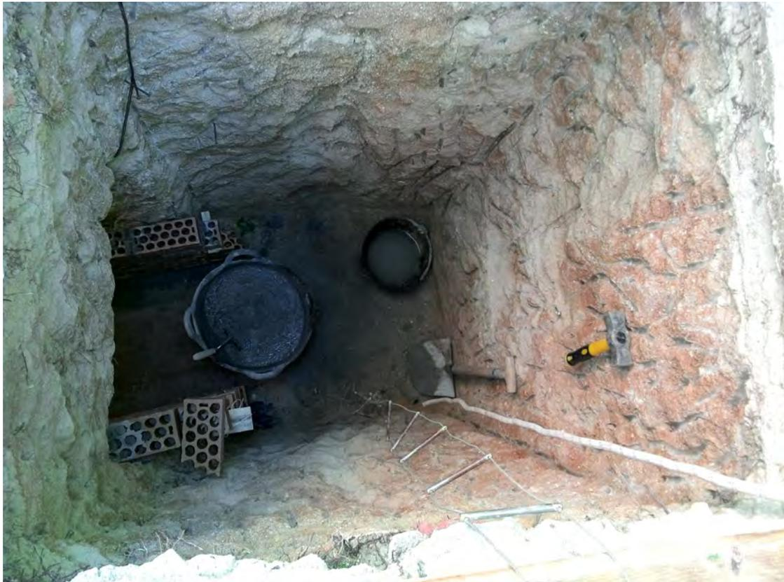
Fig. 38: "Falso pozo" realizado en una terreno de gran consistencia, para permitir el acceso a una galería en mina que se está ejecutando. Nótese el acceso a través de una escalera flexible.
