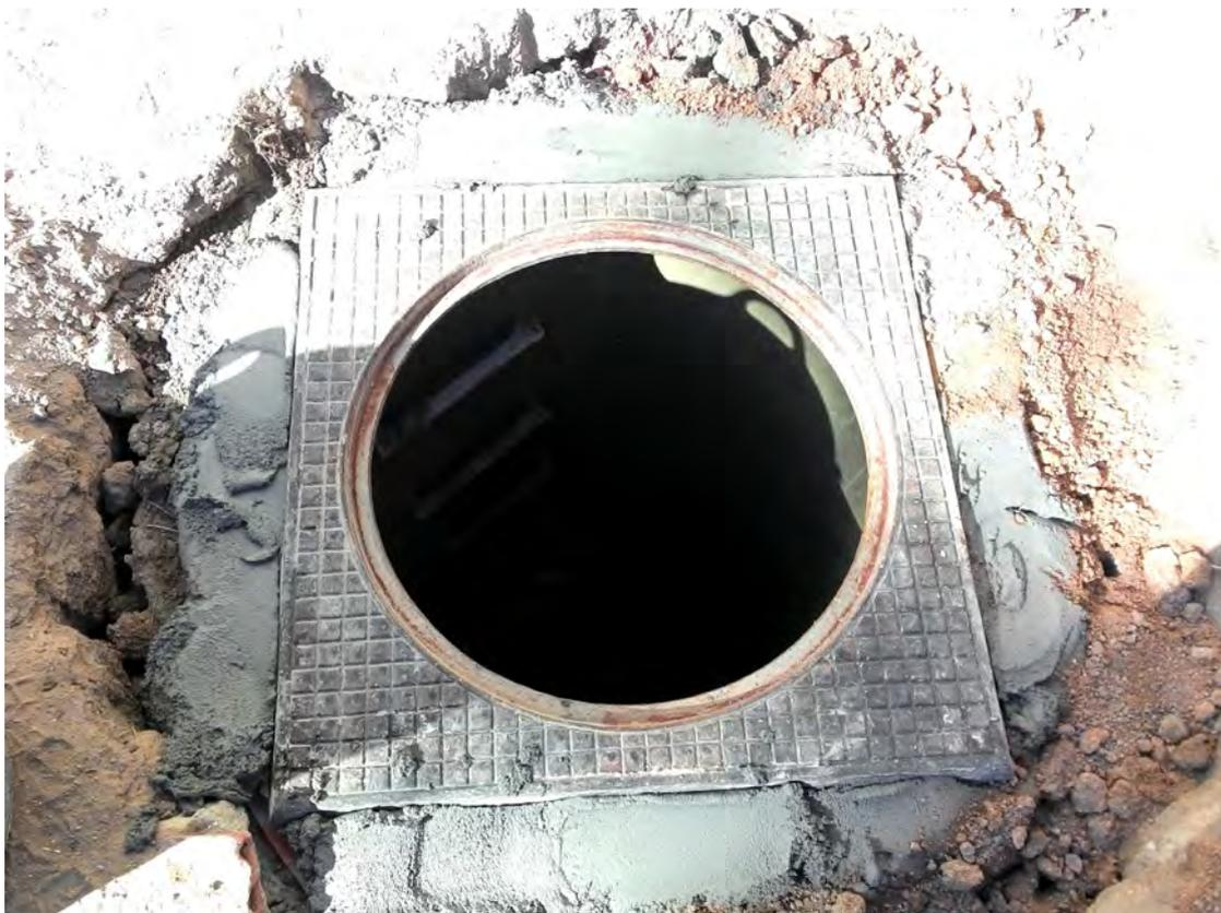
Fig. 31: Tapa dispuesta en la boca de acceso a un pozo que conduce a una galería de saneamiento.
