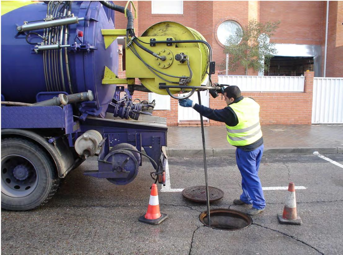
Fig. 5: Operario introduciendo el dispositivo de agua a presión en el interior de una alcantarilla para su limpieza, siguiendo una práctica habitual pero incorrecta: el operario no está protegido contra la caída.
