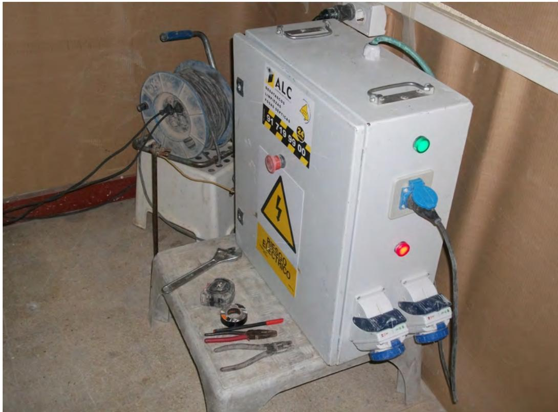
Fig. 23: Cuadro eléctrico para suministro de energía, con su transformador de seguridad de 24 V (abajo y su toma de tierra).
