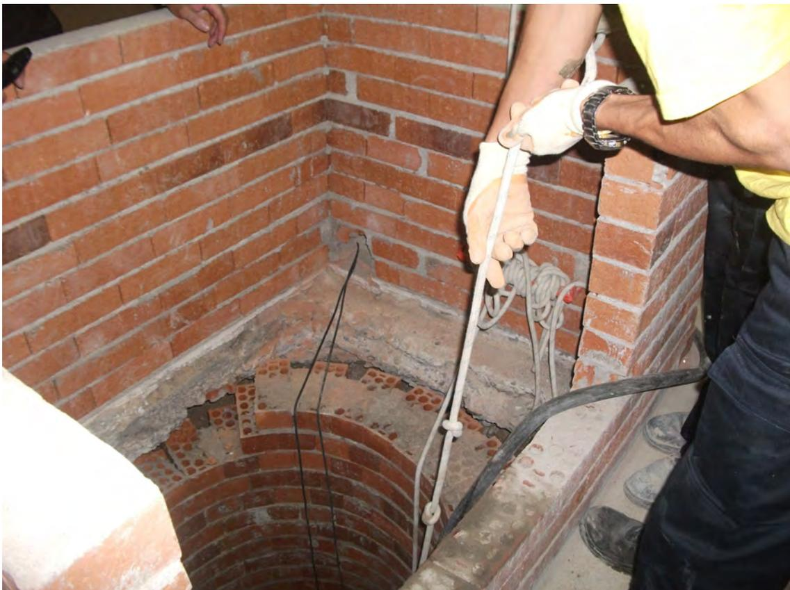
Fig. 26: Descenso indebido de material a través de un pozo. Se ha de emplear el maquinillo y el operario ha de contar con protección contra la caída.
