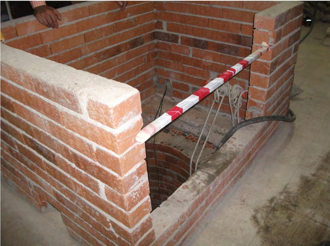
Fig. 27: Peto de protección perimetral, dispuesto en el perímetro del pozo.
