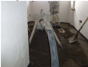
Bomba para vertido de hormigón
