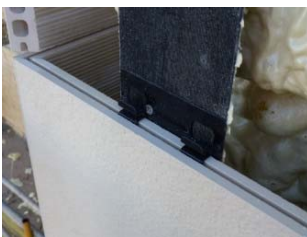
Detalle del anclaje de la pieza
