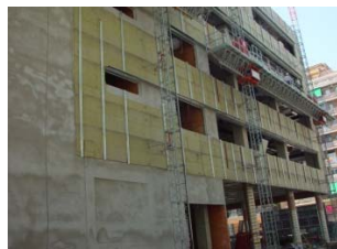
Lana de roca en fachada ventilada
