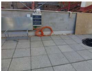
Cubierta con losa filtrante
