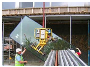
Elevación de vidrio con ventosas de vacío (2 ventosas)
