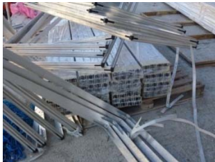
Acopio de perfiles metálicos
