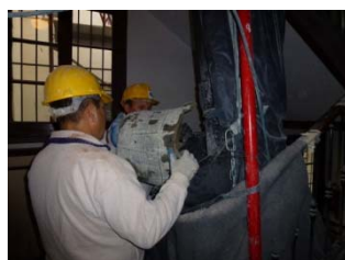
Vertido de escombros en trompa de vertido
