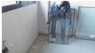
Posicionado manual de vidrio
