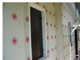
Panel poliestireno sistema SATE
