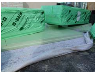
Geotextil y paneles rígidos XPS
