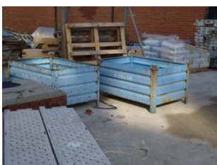
Contenedores de material (grúas)
