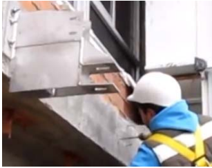
Montaje de estructura soporte
