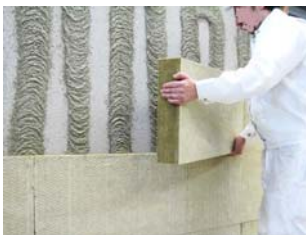
Montaje paneles SATE
