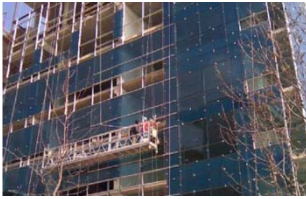
Muro corina acristalado
