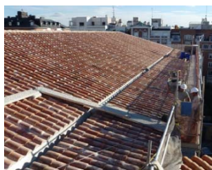
Pasarelas de acceso/paso en cubiertas
