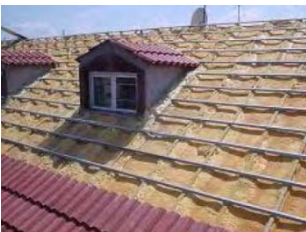
Aislamiento bajo teja con espuma de poliuretano
