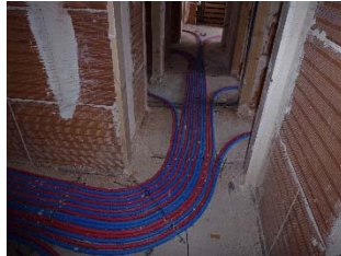
Circuito calefacción por suelo
