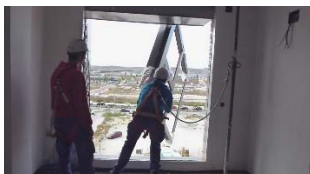
Recepción de carpintería en hueco
