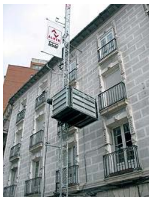
Montacargas vertical de fachada
