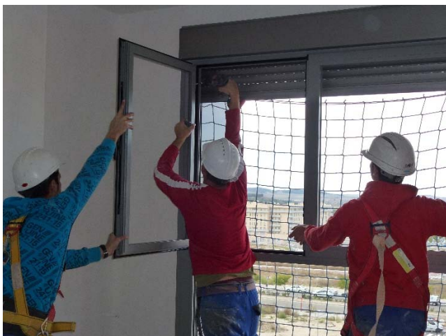
Montaje y fijación de carpintería exterior
