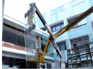
Izado a zona de colocación
