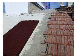
Paneles aislantes bajo teja
