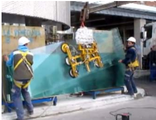
Inicio de izado de vidrio
