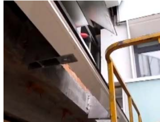
Montaje perfil inferior
