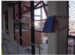
Estructura auxiliar Fachada panel
