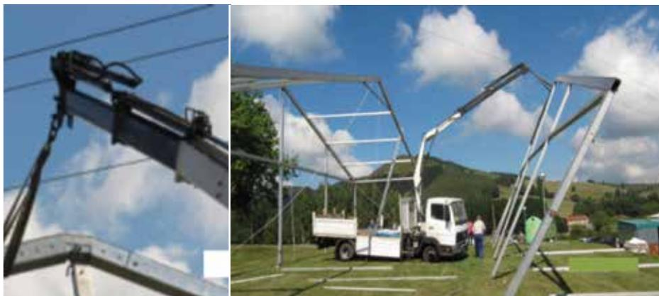
Cuando en la realización de trabajos de montaje de elementos exista la presencia de líneas eléctricas aéreas y éstas no se puedan desviar o cortar su suministro, el contacto directo o proximidad de partes de la grúa con los cables del tendido se deberá evitar mediante la instalación de elementos que delimiten las zonas seguras de trabajo (por ejemplo pórticos de balizamiento, apantallamientos, obstáculos en el área de trabajo).
