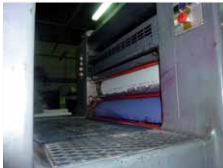
Barras de atrapamiento fijos. Fuente: DIN Impresores
