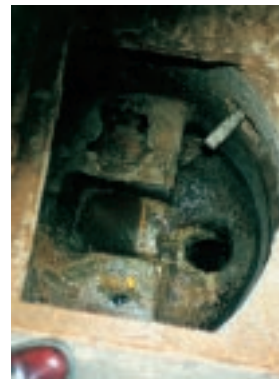
Figura 2: Interior de la arqueta
