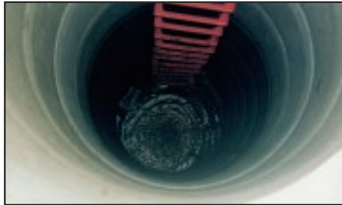
Figura 2: Interior del pozo
