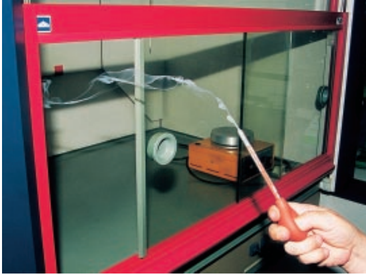
Ventilación forzada en una vitrina de laboratorio
